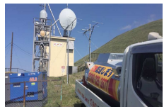
公共放送局の発電機への給油
